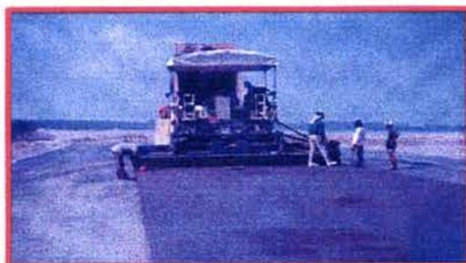
**Fig. 5.8 Pavimentadora de concreto ABG Mod. TITAN-511, con equipo de compactación.**
