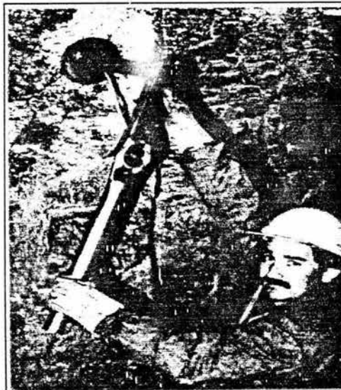
FIGURA V.11 USO DE UN APRETADOR DE PALANCA PARA TENSIONAR UN ANCLAJE
