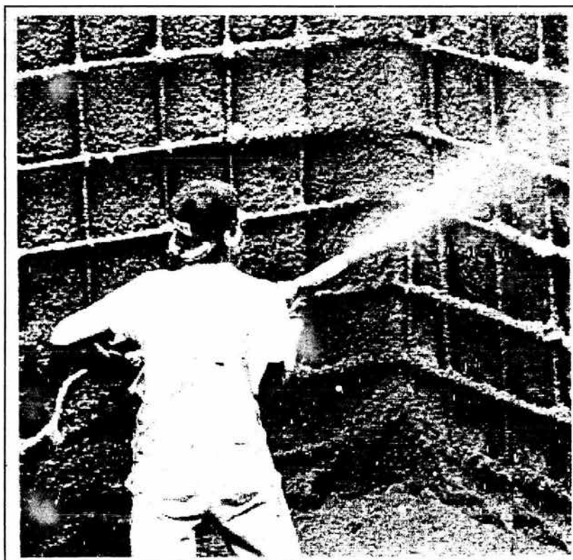
FIGURA I.3 CONCRETO LANZADO POR VÍA SECA
