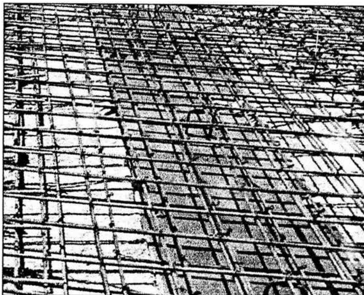
FIGURA II.26 SEPARACION DEL ACERO ANTES DEL COLADO DE UNA LOSA EN LA CIUDAD DE MEXICO D.F. 2002
