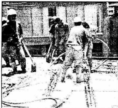
FIGURA II.32 ENRASADO DE CONCRETO POR ROTACION
