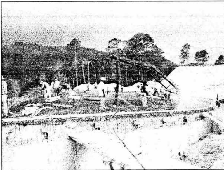
FIGURA II.5 COLADO DE UN FIRME DE CONCRETO ARMADO DE UN PUENTE CARRETERO TEZIUTLAN, PUEBLA JULIO DE 2002
