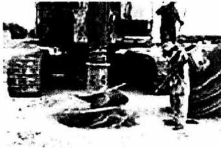
Fig.36 Perforación de Pila de Cimentación
