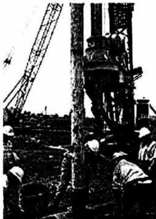
Fig.40. Colocación de Tubería Tremie
