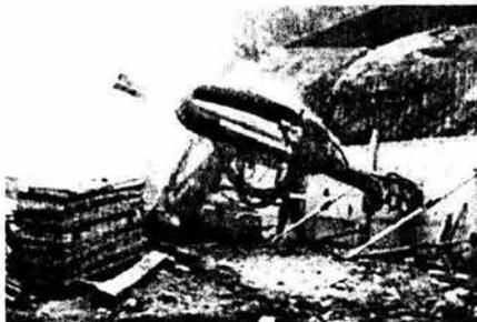
Fig.4 Perforación de barrenos
