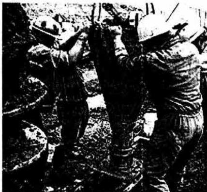
Fig.39 Cono de Remate del Tubo Tremie.
