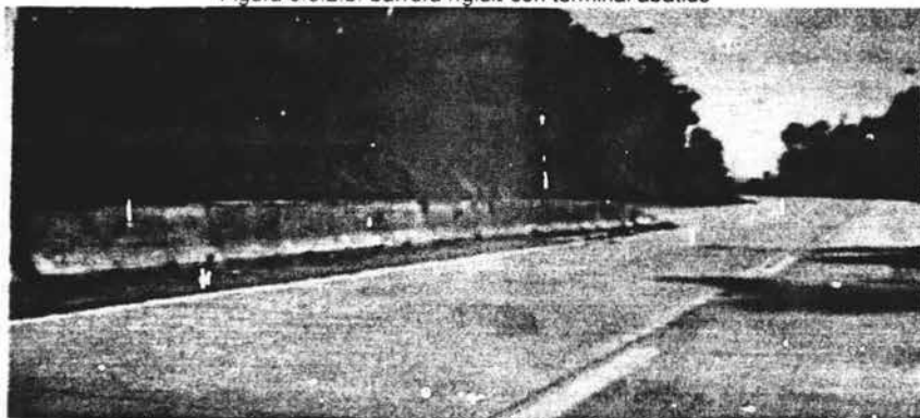
Figura 8.6.2.b. barrera rígida con terminal abatido
