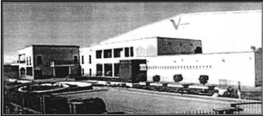
Empresa de enfriadores S.A de C.V. San Juan del Río, Querétaro
