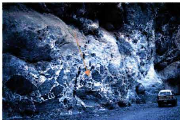
Ilustración 14 Junta, visible donde indica la flecha. Cortesía de Carlo Giovanella.
