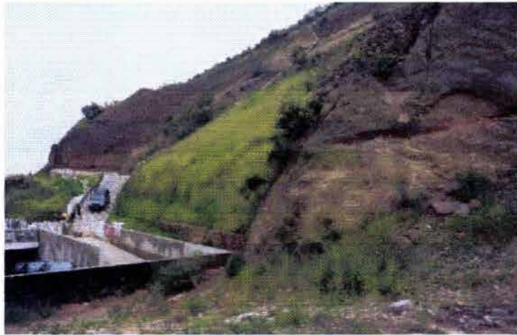
Ilustración 61 Muro estabilizado y revegetado a base de geotextiles y geoceldas. Sta Fe, DF.
