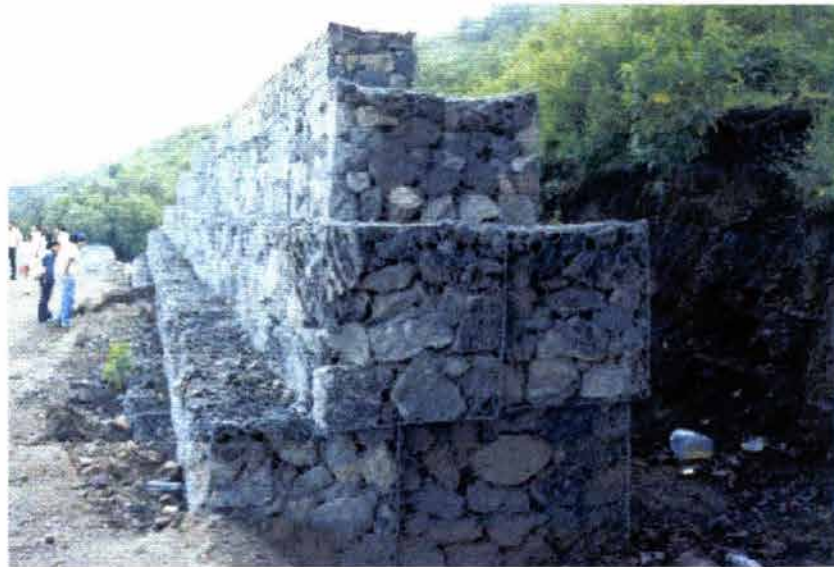
Ilustración 57 Muro de gavión. Este muro es de los llamados de alcancía, puesto que su finalidad es la de contener los caídos provenientes de la ladera. Del. Iztapalapa D.F., México
