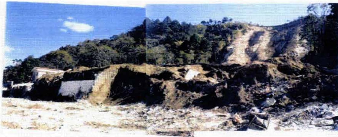
Figura VIII. 19 Muro de contención que delimitaba originalmente la urbanización . Nótese las construcciones hacia la ladera
