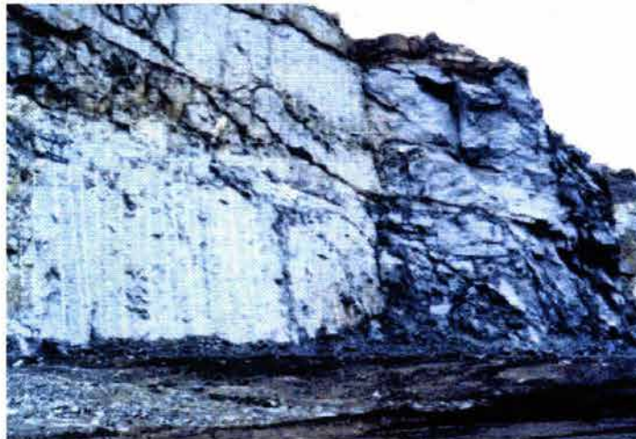
Ilustración 60 Comparación de resultados con dos técnicas de corte con explosivos, en Gneiss. Ref.17
