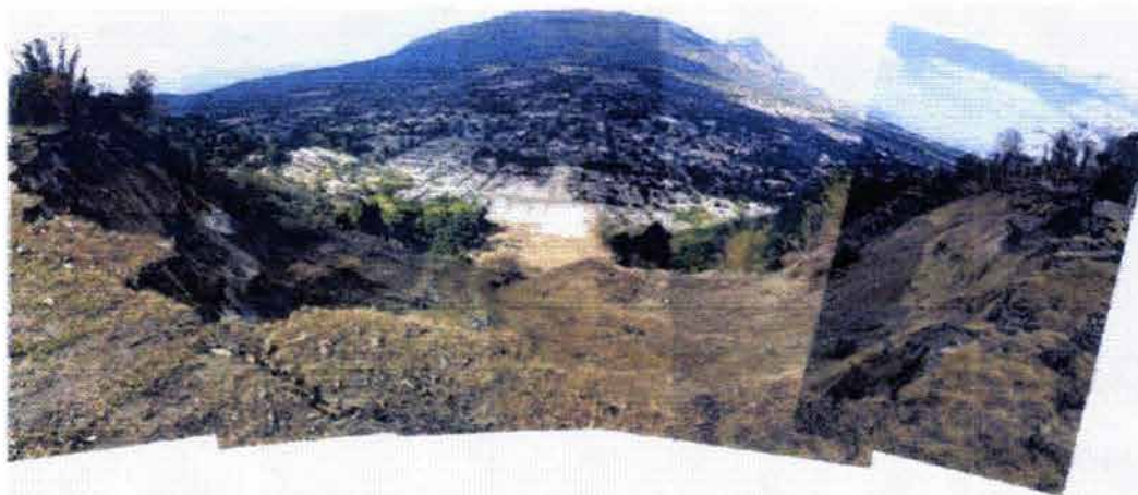
Figura VIII. 20 Vista de la ladera “Las Colinas” desde la corona de la zona fallada
