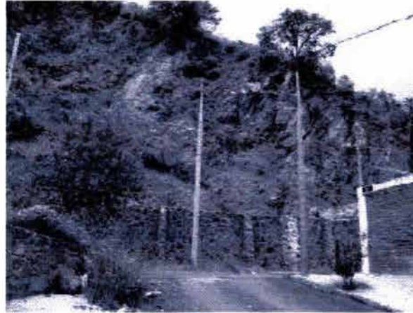
Figura VIII. 5 Fotografía de un banco abandonado en el que se pueden observar las dimensiones de los bloques, así como las discontinuidades presentes en este macizo rocoso.
