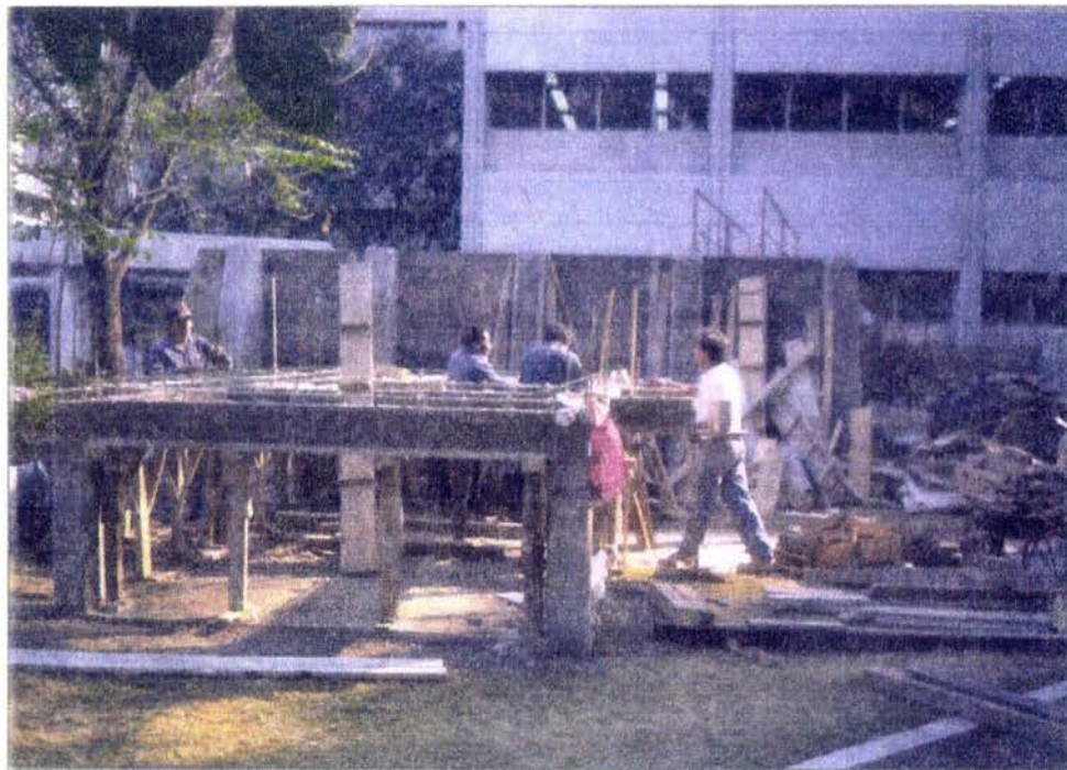
Fig 3.2 Area del laboratorio del Instituto de Ingeniería proporcionada para construir el modelo
