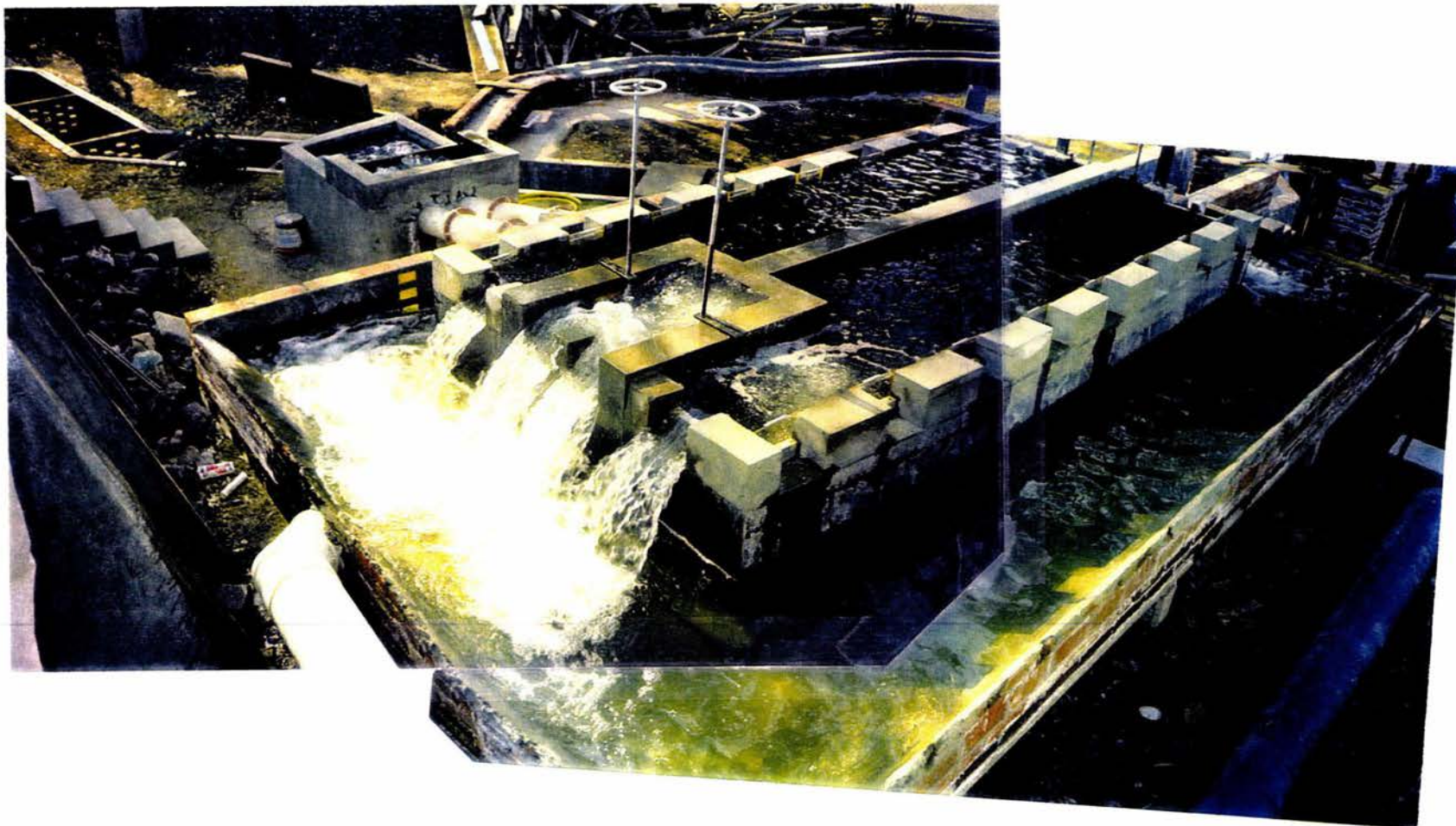
FOTO 6. Vista panorámica del tanque y del funcionamiento de canal perimetral
