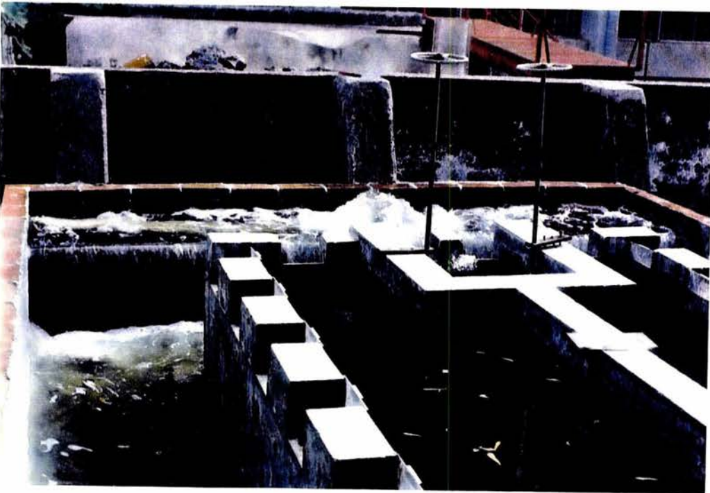
FOTO 14. Funcionamiento de la descarga propuesta junto con el cimacio (nótese que el tanque de aguas claras ya no se encuentra sometido a la presión de llegada del flujo)
