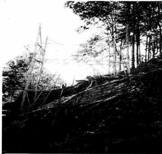
Armado y nivelado de Bottom Panel
