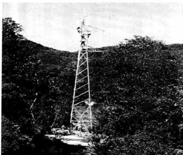
Armado de torre
