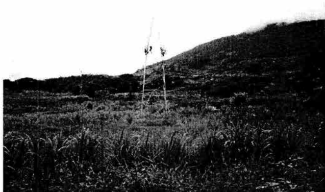
Construcción de L. T. en tierras ejidales
