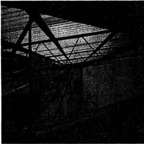
Estructura de lamina y acero
