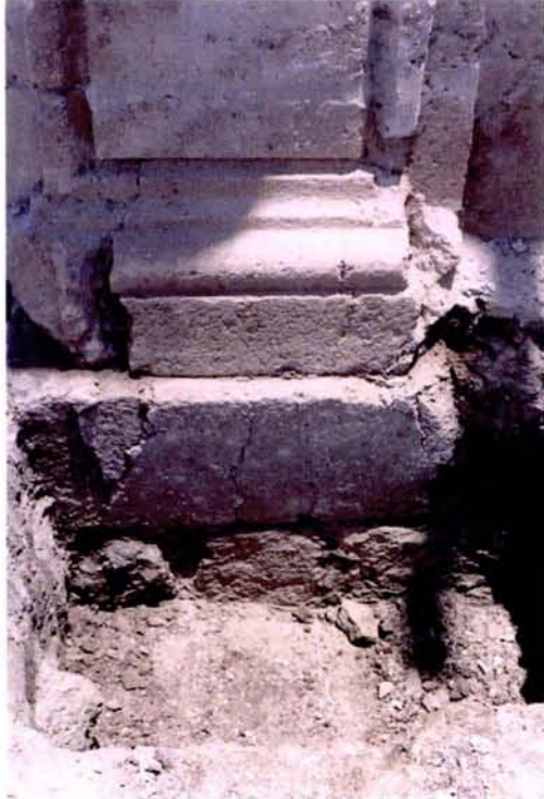
Cala en la basa de la Portada lateral.
