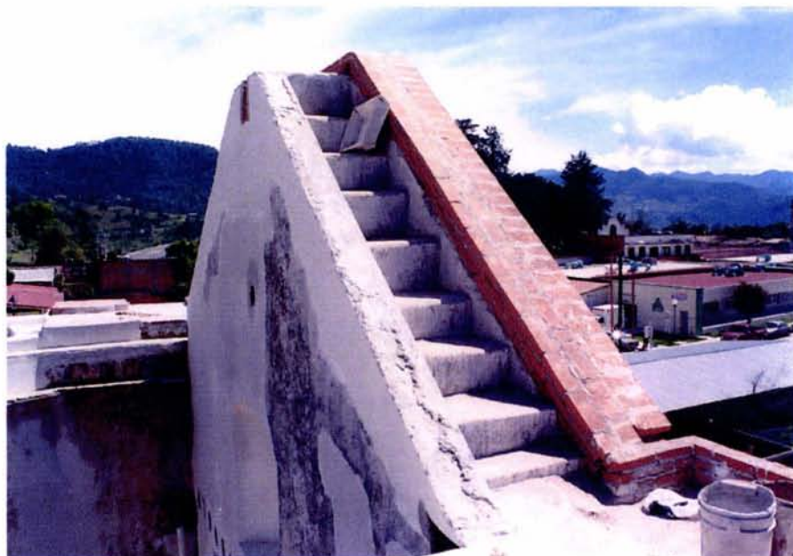
Reposición de la mampostería en el remate del Imafronte.
