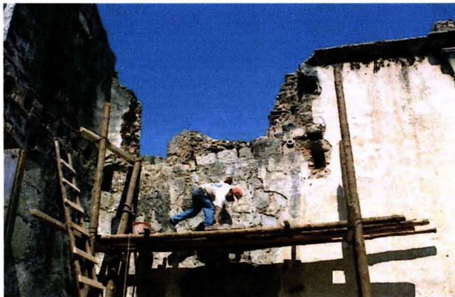
Derrumbe del muro en el acceso al coro.
