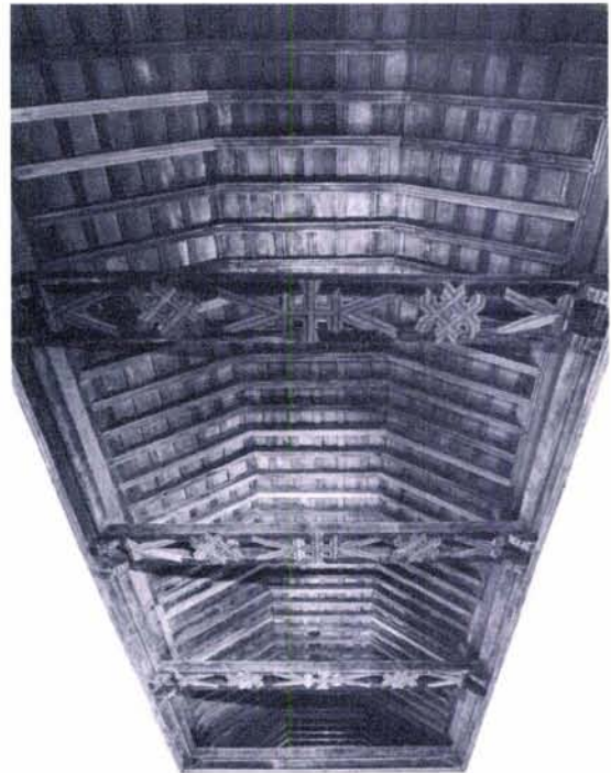
Armadura de cubierta en “par y nudillo” en Cartagena de Indias, Colombia.
