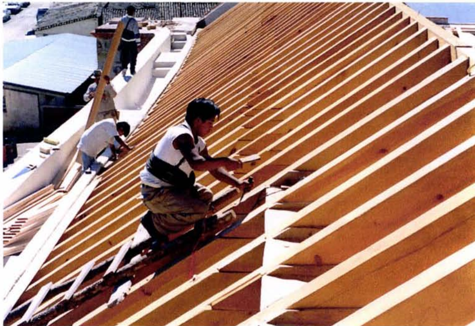
Colocación de la duela en la parte central del artesón, en el punto donde cambia de dirección.
