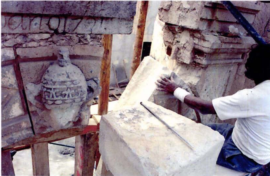
Desmontaje y reacomodo de las dovelas de la Portada lateral.
