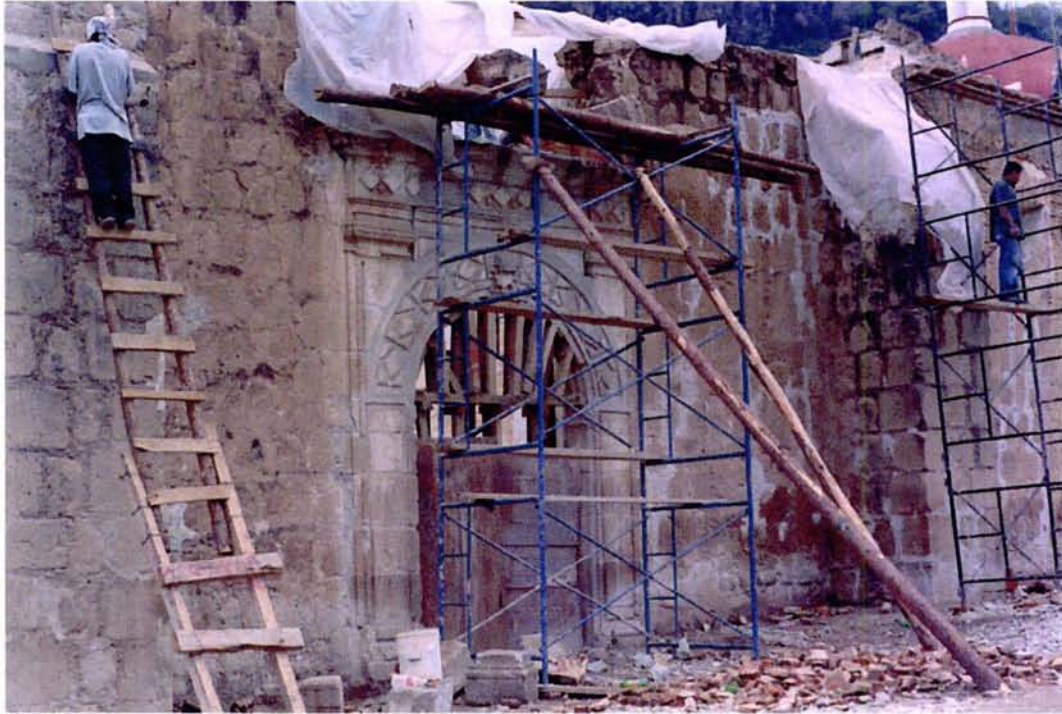
La portada lateral en proceso de restauración.
