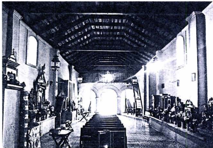
Abajo. Vista interior hacia el coro.
