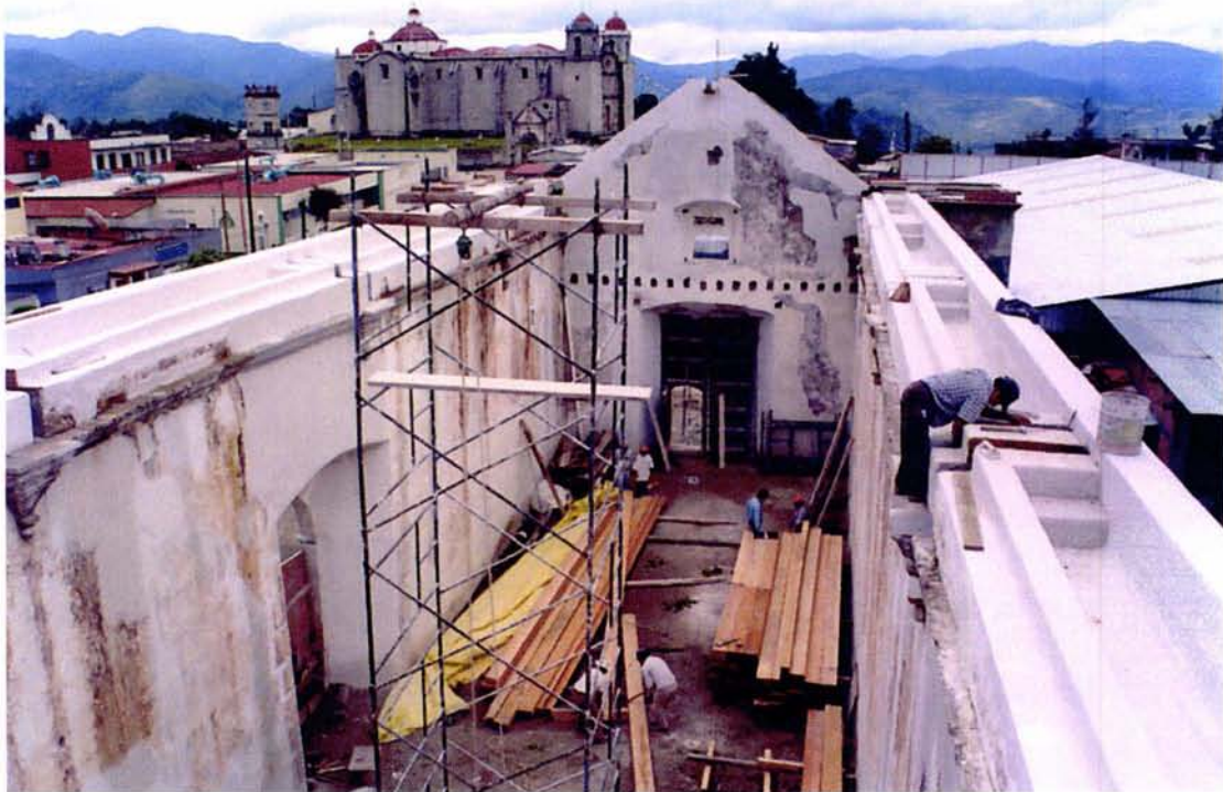
Preparativos para el montaje de la cubierta de madera.
