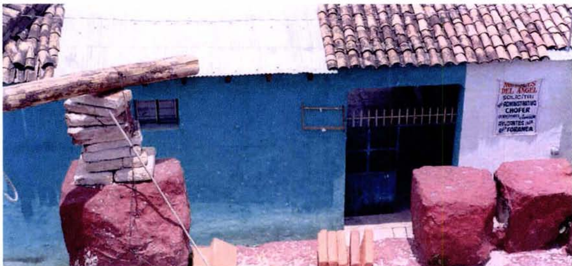
Casa con tejado en proceso de sustitución. Villa de Ixtlán. Oaxaca.
