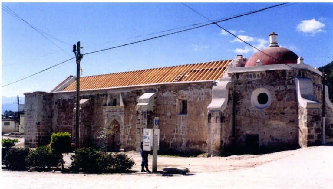
El templo de San Francisco de Asís, en su proceso de rescate y restauración.
