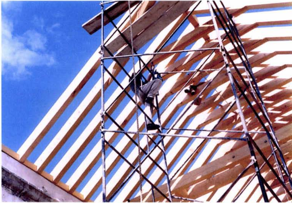
Ensamble del nudillo al centro del maderamen.
