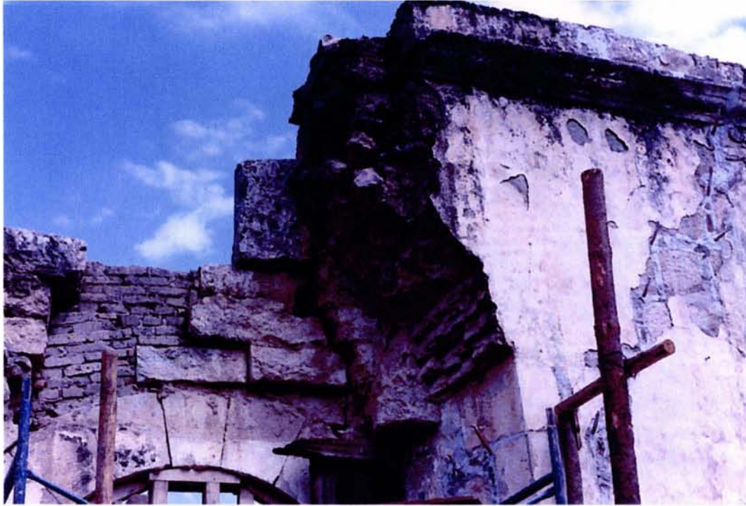
Restos del arranque del arco capialzado de ladrillo, en el acceso lateral.
