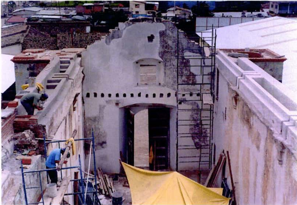
Restauración de los canales en los remates de los muros de la nave.
