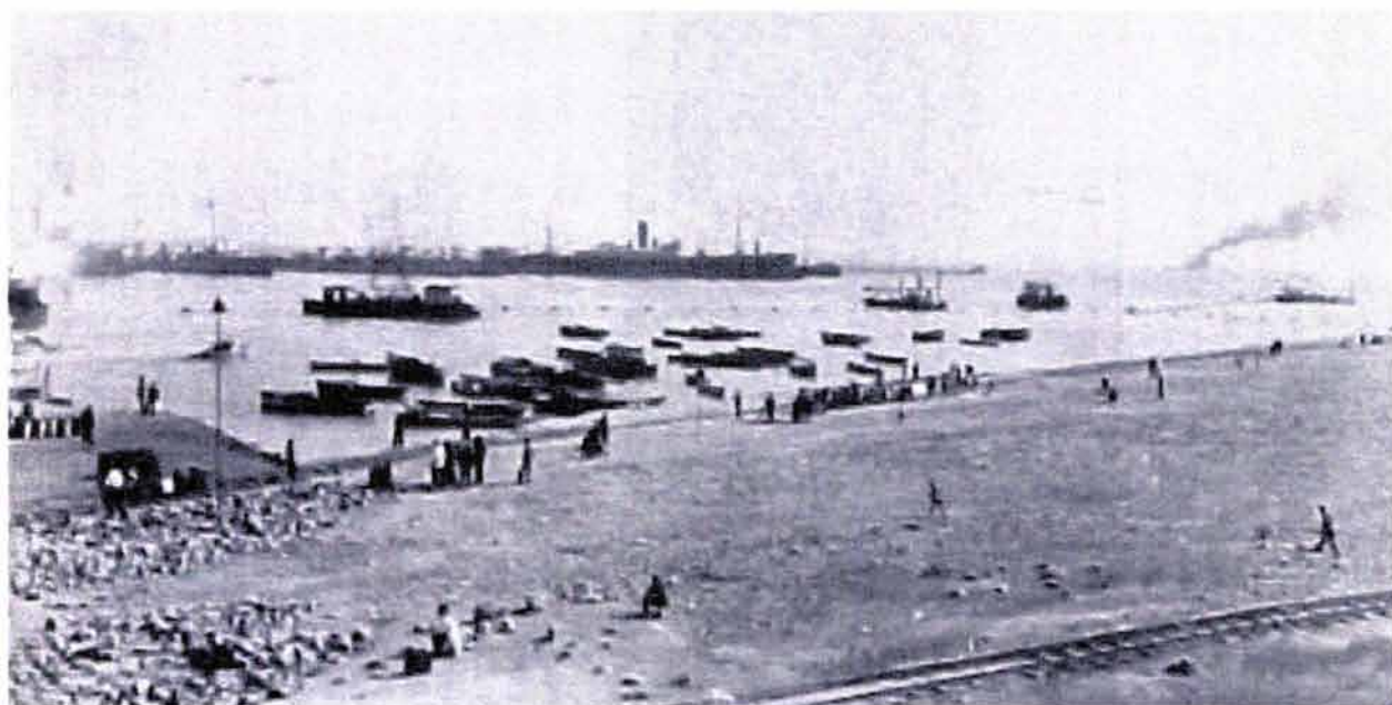
FOTO 27. Las obras del Puerto de Antofagasta, casi terminadas en 1929.
