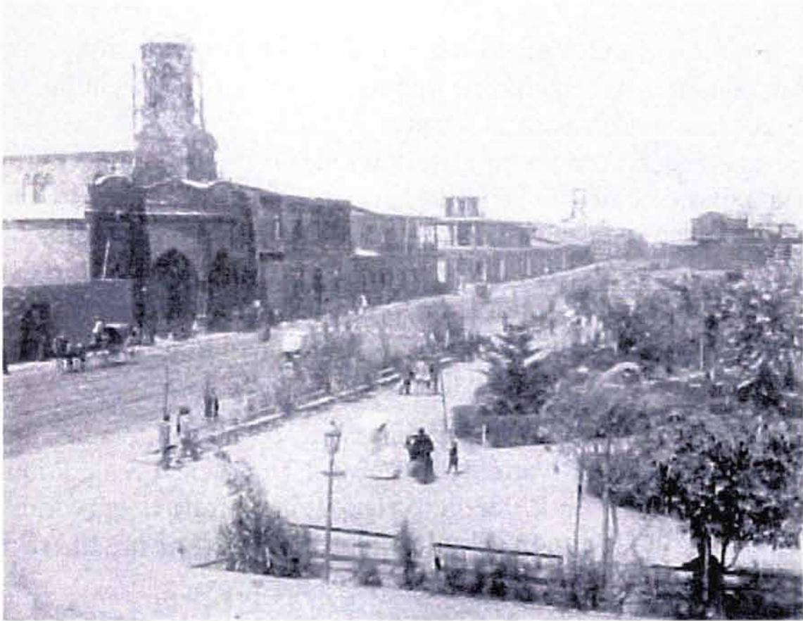
FOTO 15. Iglesia de Antofagasta destruida por otro incendio.
