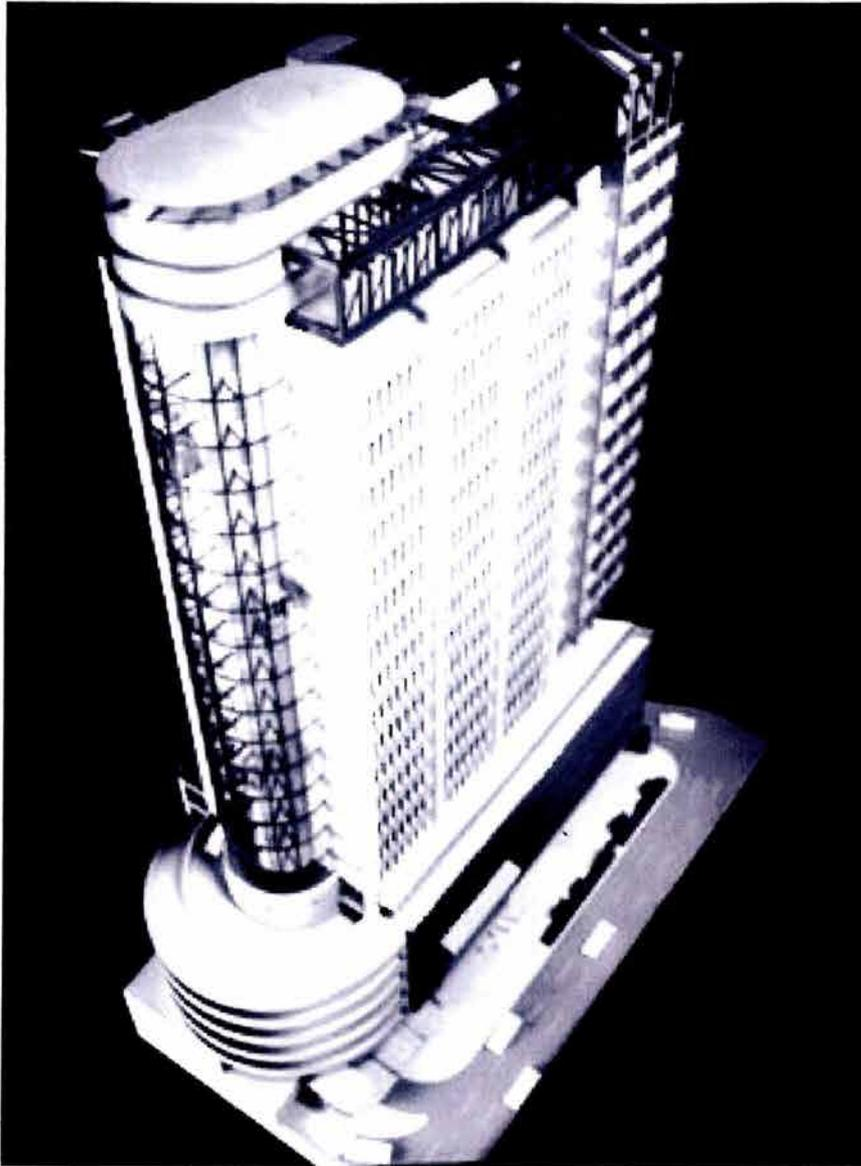
Se optó por sistema mixto de estructura, concreto en columnas y acero en traveses y armaduras y sistema de piso con lámina estructural. Las columnas de concreto trabajarán a compresión en el perímetro del volumen esbelto de oficinas, mientras las deformaciones horizontales las absorberán las traveses metálicos y la losa, en conjunto intercalando de uno los niveles de oficina que tendrán al tercio de claro unos eslabones de cortante estabilizando la estructura horizontalmente.
