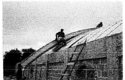
*Procedimiento de instalación de la cubierta auto-soportante por medios manuales.*
