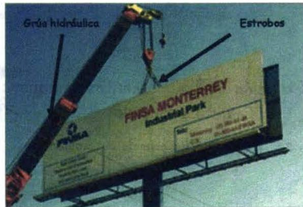
Foto 23. Instalación y montaje del anuncio, con grúas de diversas capacidades, según las necesidades del trabajo
