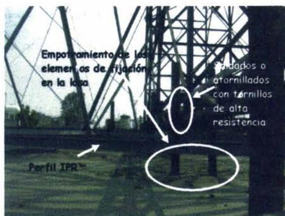
Foto 13. Elementos de fijación de un anuncio de azotea
