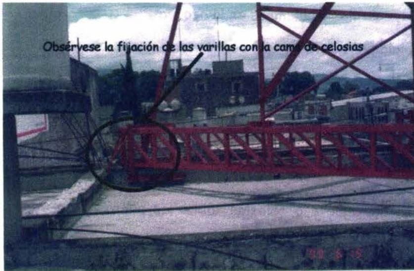
Foto 26. Fijación de la celosía que conforman la cama de viguetas para el desplante del anuncio
