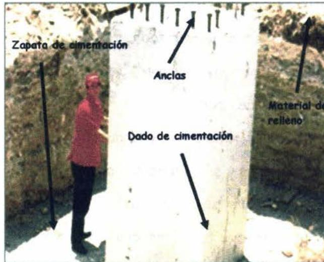
Foto 20. Dado de la cimentación y preparación de las anclas para recibir placa base
