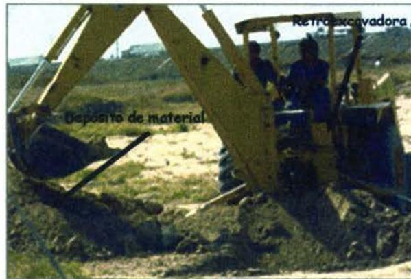
Foto 17. Excavación del terreno por medios mecánicos para desplante de la cimentación
