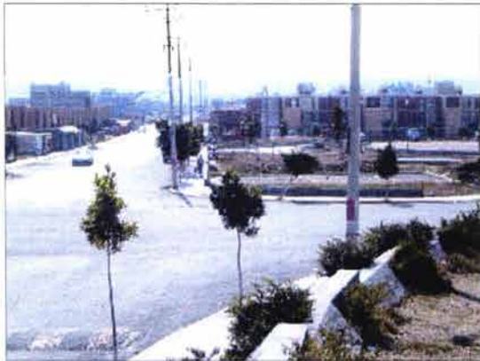
05-vista de calle Benito Juárez hacia el oriente.
