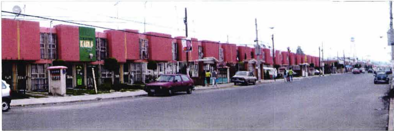
02-vista sobre calle Independencia hacia norte.
