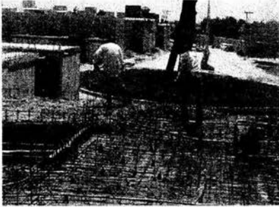
Imagen de una losa de una casa del proyecto Quintas de Montecarlo, Cuautitlán Izcalli
