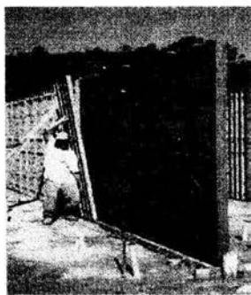
Fotografías ilustrativas de la colocación y descimbrado de los moldes
