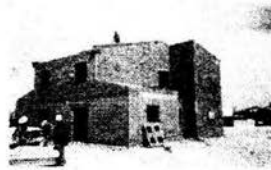
Construcción con ladrillo
