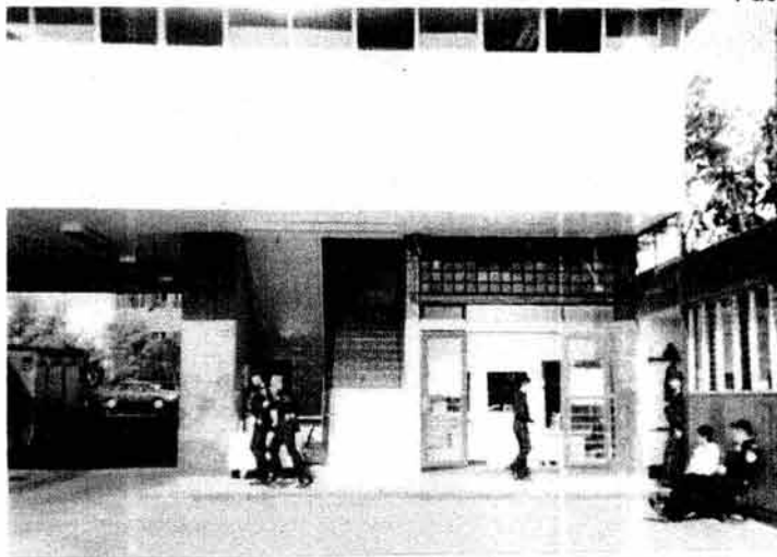
Vista de Sala de Alarmas
