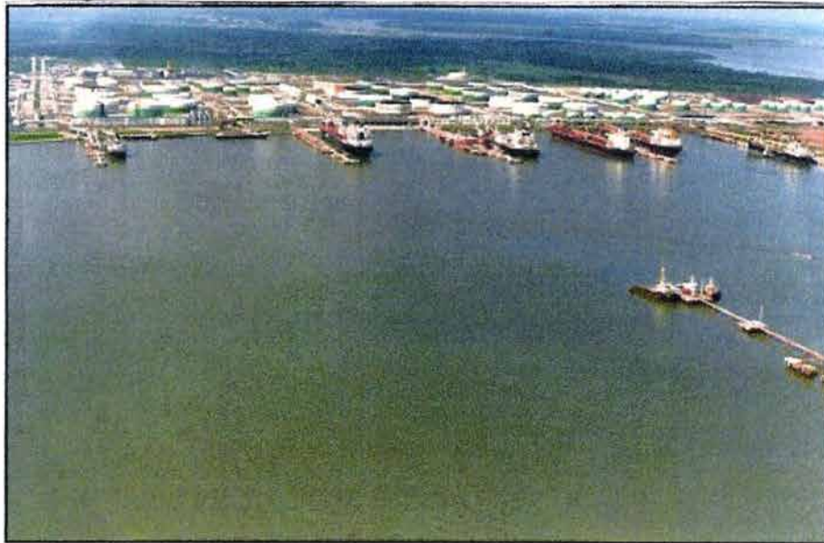
Figura 5. Muelle Industrial Pajaritos. (Terminal gas.)
