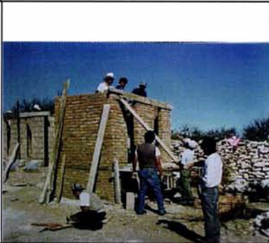
Construcción de caseta para letrina seca realizada por el Grupo DESICA.
