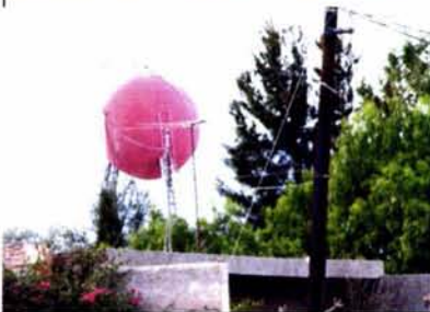
Tanque de agua que se encuentra en Emiliano Zapata
