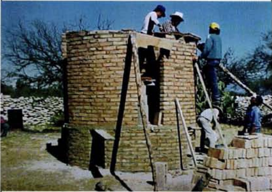
Dos diferentes formas para construir la caseta de la letrina.
