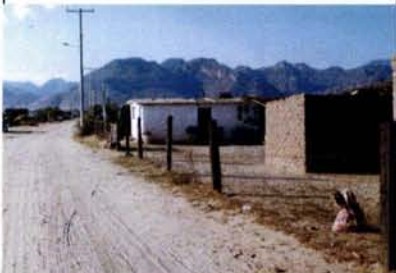
Calle principal electrificada de La Presita
