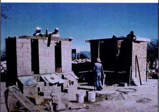
Dos diferentes formas para construir la caseta de la letrina.
