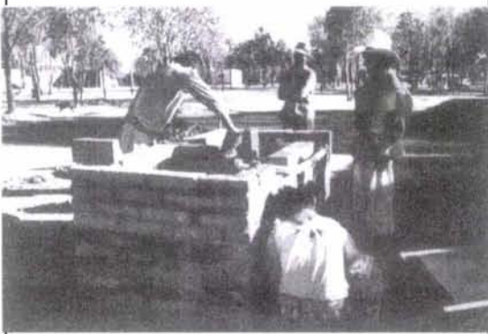
Instalación hidráulica del sanitario
