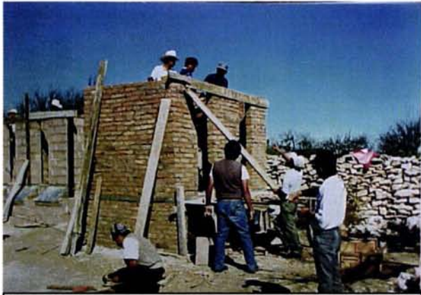
Construcción de letrinas secas.
