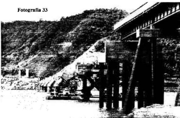
fotografía 33 Vista de lo que será la unión del puente "Chiapas 1" al ligarse en el estribo 1 con la superestructura de otro puente de secciones menores.
