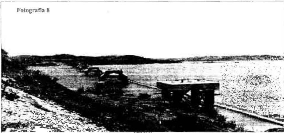
Las fotografías 7 y 8 presentan una vista de la subestructura, la cual consta de 7 apoyos metálicos a base de tubo y dos estribos de concreto. En los apoyos centrales se puede observar el cambio de cabezal y el reforzamiento del mismo ya que serán los que reciban las cargas de la superestructura en los claros de mayor longitud.
