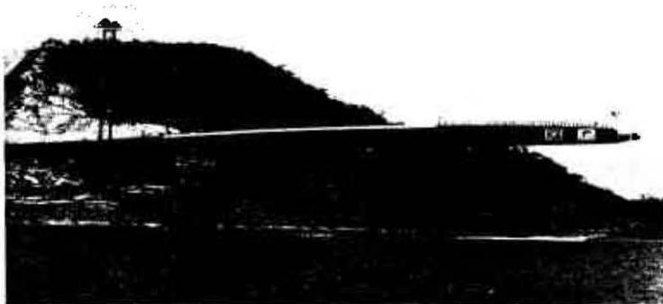
**FASE 7:** Se continúa con el lanzado del tramo 7 y 8, y una vez alcanzada la longitud de volado desde la pila no.8 incluyendo la nariz, cuya longitud será de 136 m, se procederá al tensado simultáneo de los tirantes no. 2 con una fuerza de 280 t cada uno, mientras que los tirantes no. 2' se tensarán con una fuerza de 260 t cada uno. Dichos tirantes se ligarán con las orejas de las dovelas D4 y D18, como se muestra en la figura 3.4.8.
