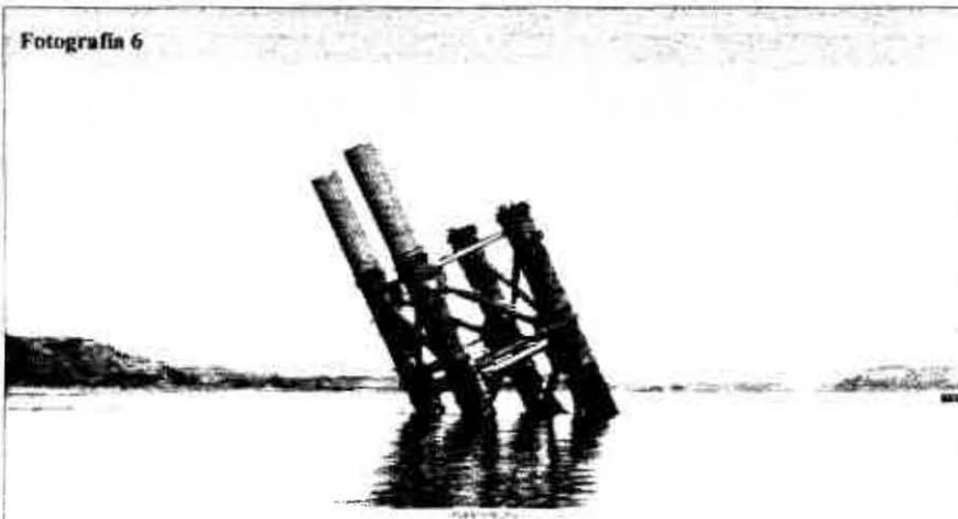
En las fotografías 5 y 6 se puede apreciar el momento en que se destapan los flotadores de extensión, para dar inicio al posicionamiento final de la pila.
