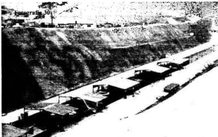
La fotografía 30 presenta una vista de las cubiertas móviles de protección durante el proceso de aplicación de soldadura, instaladas en los corredores laterales de la fosa de armado.
