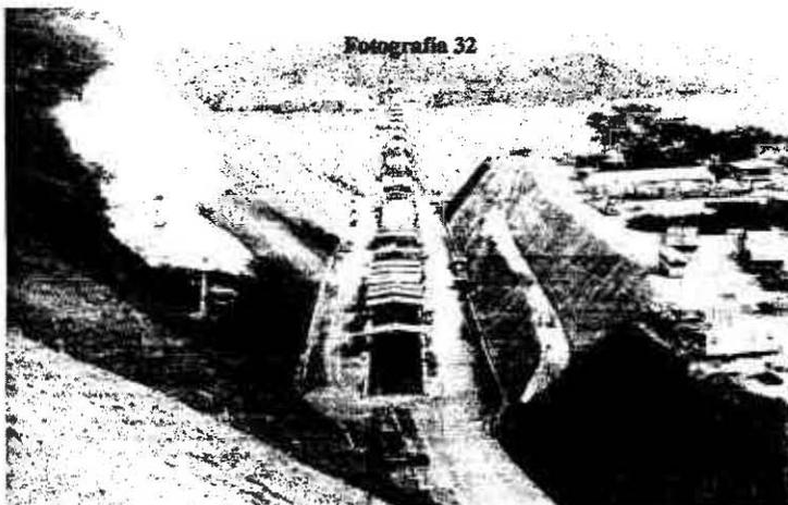
La fotografía 32 presenta una vista general de la línea de ensamble de la superestructura con respecto a los apoyos definitivo, apreciándose que el puente se ubica de forma recta.
