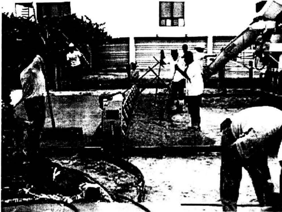
Figura 5.9. Enrasamiento del material ya distribuido, por medio de rodillos o de forma manual
