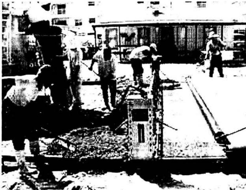
Figura 5.12. La descarga del material es continua
