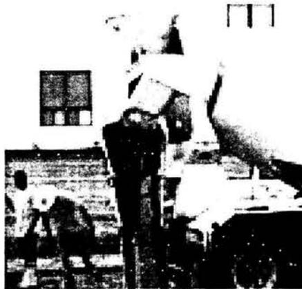
Figura. 5.1. Camión revolvedor descargando con la máxima abertura del canalón, la mezcla de concreto permeable
