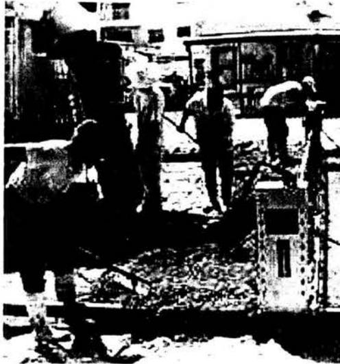
Figura 5.4 Distribución de la descarga del material la cual debe ser rápida y continua
