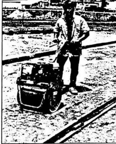
Figura 4.4. Compactar con un equipo vibratorio según lo establecido en la norma
