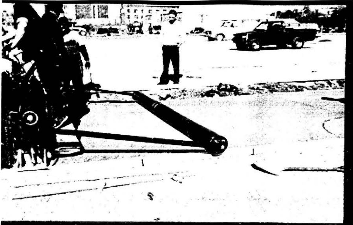
Figura 5.11 Enrasamiento del material ya distribuido, por medio de rodillos
