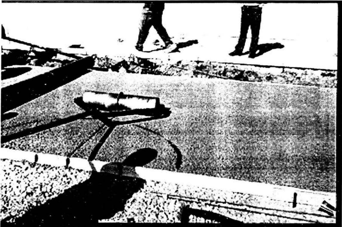
Figura 5.21. Junta transversal
