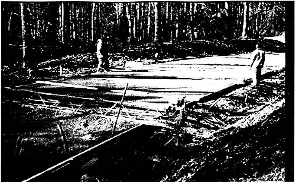
Figura 5.25. El procedimiento de curado normalmente utilizado es el de cubrir la superficie expuesta con un material de polietileno y se comenzará a cubrir después de 20 minutos de haber hecho la colocación final
