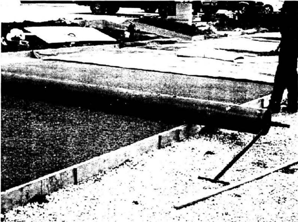
Figura 5.22. El procedimiento de curado normalmente utilizado es el de cubrir la superficie expuesta con un material de polietileno 20 minutos después de la colocación final
