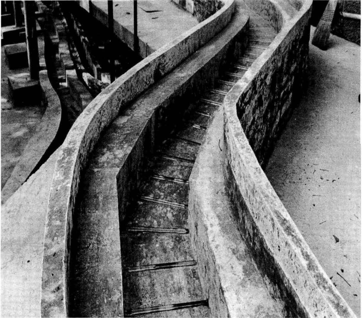
Foto 6.1 Colocación de la rugosidad artificial de fondo.
