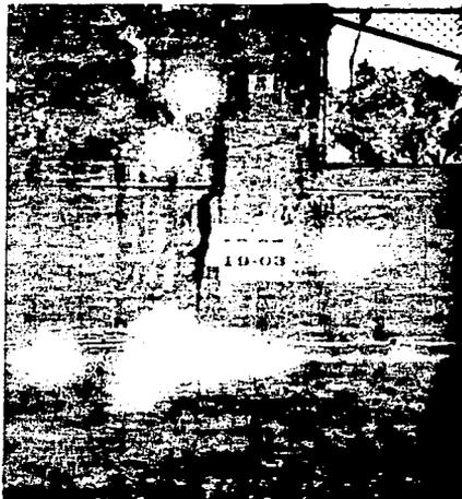
**Agrietamiento de muros en Línea "A"**
