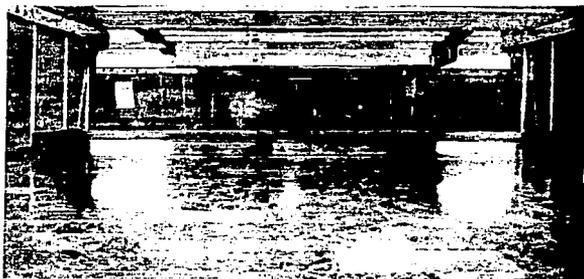
Estación Consulado.- Piso en pendiente provocado por diferencia de hundimientos
