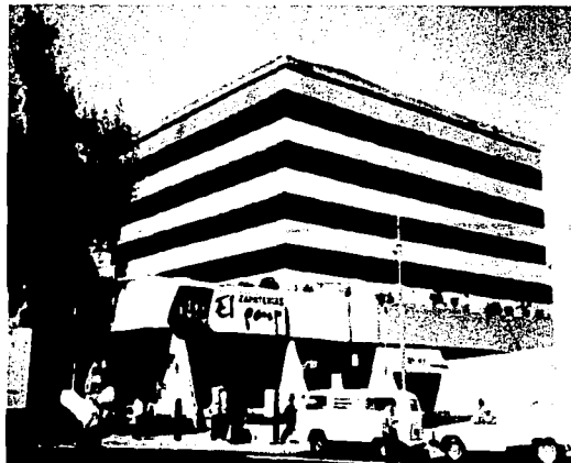
EDIFICIO COVITUR Y ACCESO METRO ZAPATA
