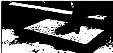
Colocación de la base de tepojal.
