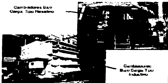
Figura 2.1.2. Cambiadores bajo carga
