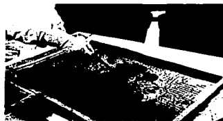
La colocación de armadura sobre el mosaico y la aplicación del mortero.
