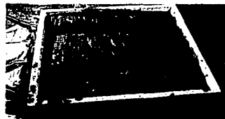
El encofrado y la malla de alambre.
