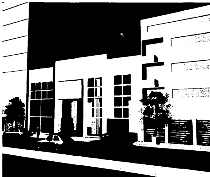
FACHADA JOSE MARIA IZAZAGA
