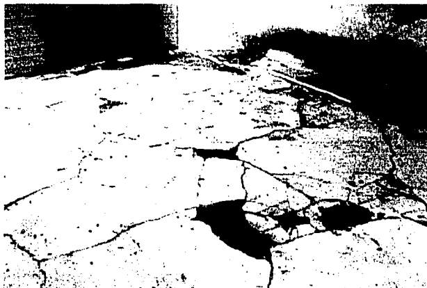
Fig. 2.16 Casa 1, agrietamiento del firme
