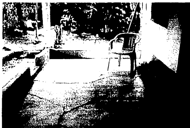
Fig. 2.18 Casa 51, agrietamiento del firme
