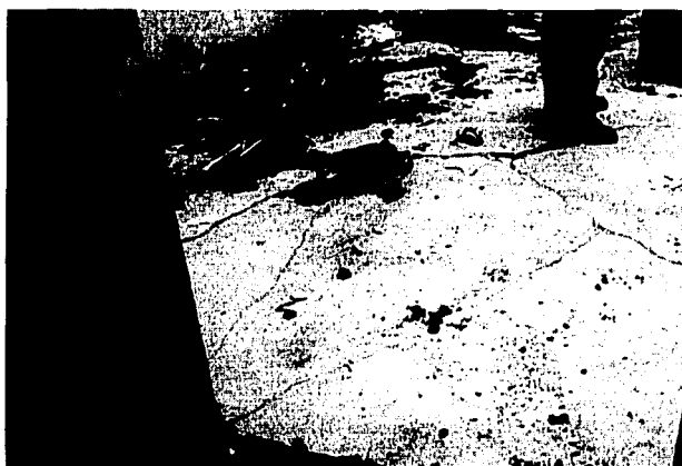
Fig. 2.17 Casa 13, agrietamiento del firme
