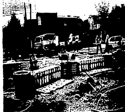
Construcción de bancas con cilindros de pruebas de concreto y tubos de drenaje.
