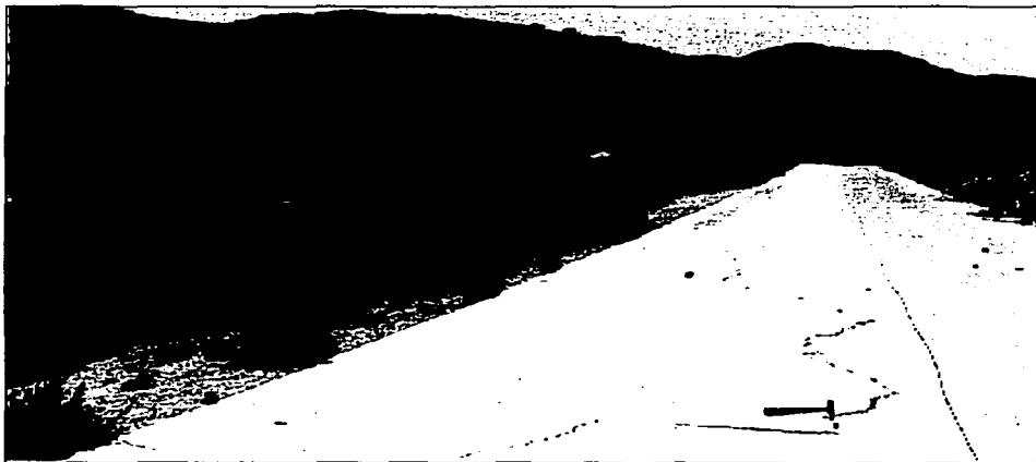
Fotografía 29. Agrietamiento del camino al monumento de Cristo Rey, indicativo del mismo fenómeno geológico mencionado.
