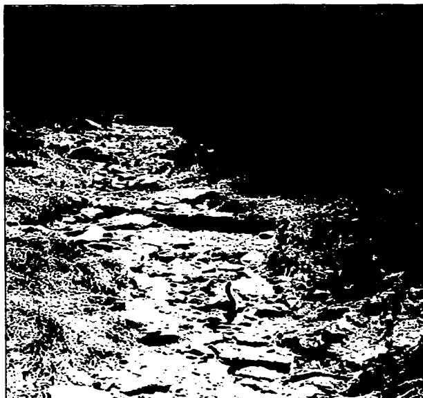
Fotografía 23. Vista hacia aguas arriba del arroyo San Pedro en su cruce con el derecho de vía , en donde se observa su poder erosivo y de arrastre, con bloques de hasta 0.60 m.
