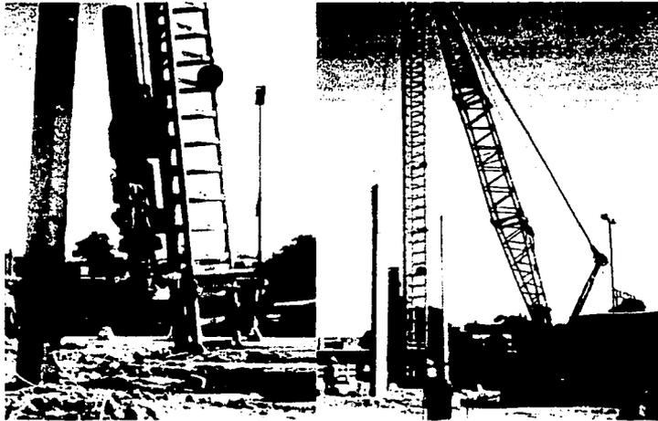
Martillo y equipo para el hincado de pilotes usados en el
