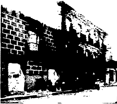
EDIFICIO ORIGINAL (DESPUÉS DL INCENDIO)
