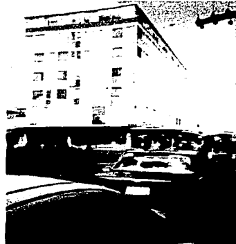
VISTA DESDE LA CALLE PROGRESO
