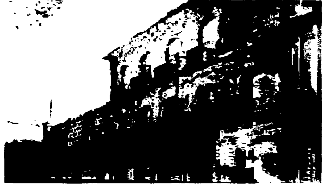
EDIFICIO ORIGINAL (DESPUÉS DEL INCENDIO)
