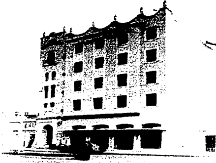
FOTOGRAFÍA DEL HOTEL RECIÉN TERMINADO
