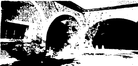
VISTA DE ACCESO PRINCIPAL.
