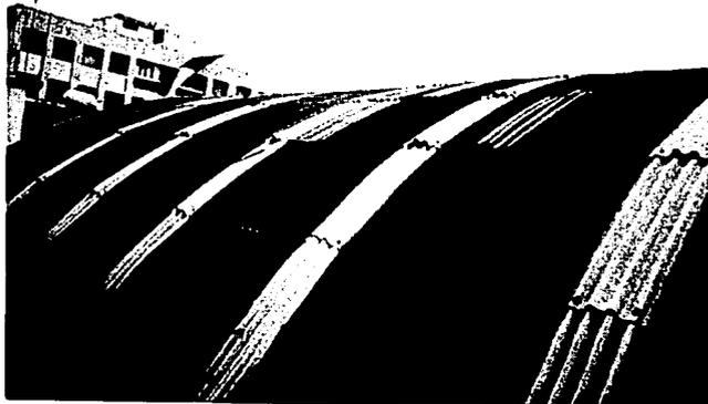
**IMAGEN NO. 6-C.**-La techumbre de la cancha es de lámina acanalada, lámina que se encuentra en total abandono, y hay secciones que ya están desprendidas.
