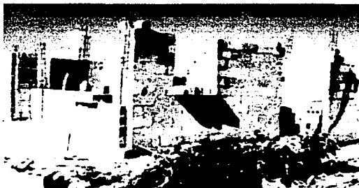
Foto 8. Muro de block y castillos
