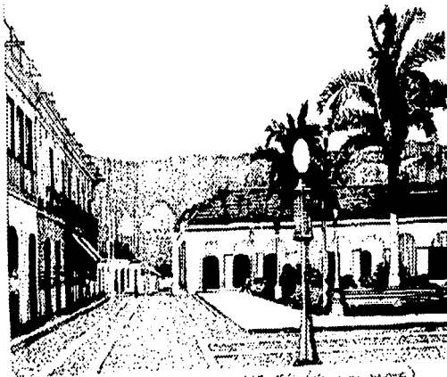
VISTA PARCIAL DE LOS PORTALES (Hacia el Norte) El primer tramo se aprecia una línea de arcadas.
