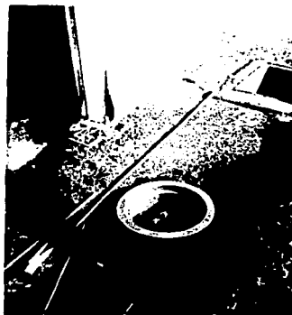
Fig. 3-13 Registro para electrodo de tierras.
