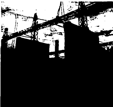
Figura 2.1.1 Banco de transformadores trifásicos 400/115/34.5kV 75/100/125MVA OA-FA-FA Podemos clasificar a los transformadores de la siguiente manera:
