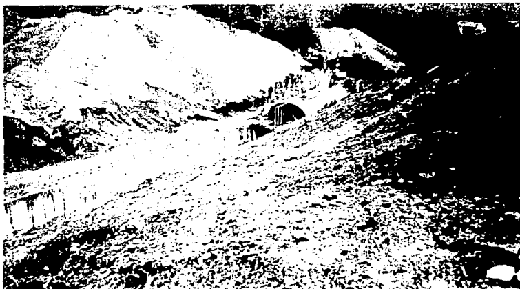
Figuras 73 y 74 Construcción de bóveda de concreto ciclópeo con cimbra metálica
