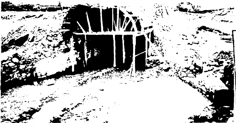
Figuras 71 y 72 Construcción de bóveda de mampostería con cimbra de madera
