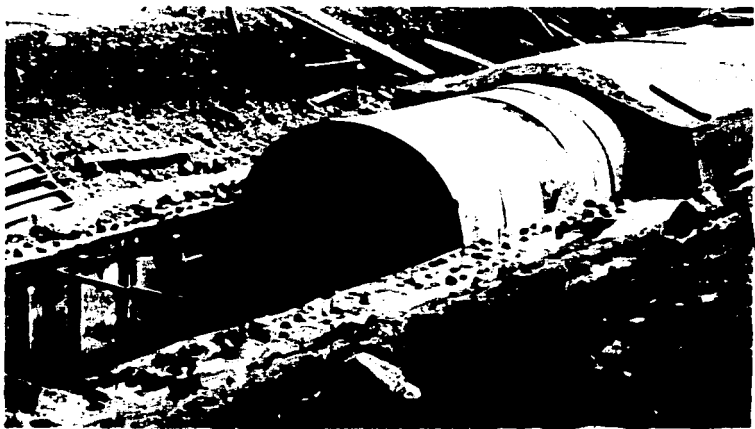
Figuras 73 y 74 Construcción de bóveda de concreto ciclópeo con cimbra metálica
