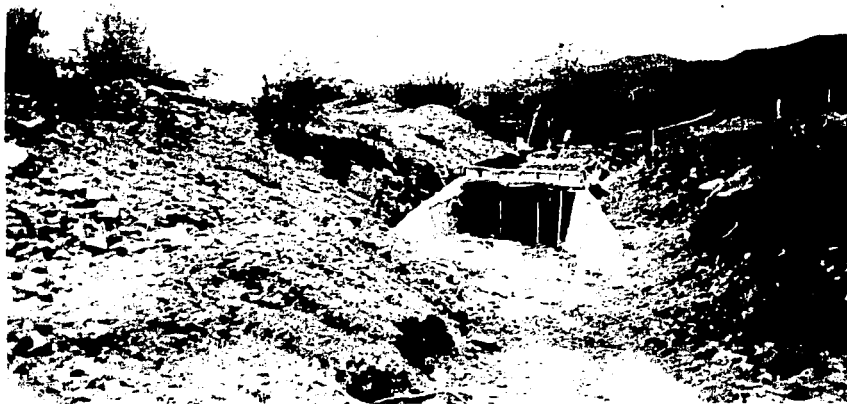
Figura 68 Construcción de losa de concreto armado
