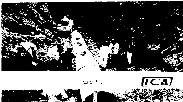
Figura 64 Construcción de tubo de concreto 0.90 m. Ø. Nótese el uso de equipo ligero para la construcción del arripe.
