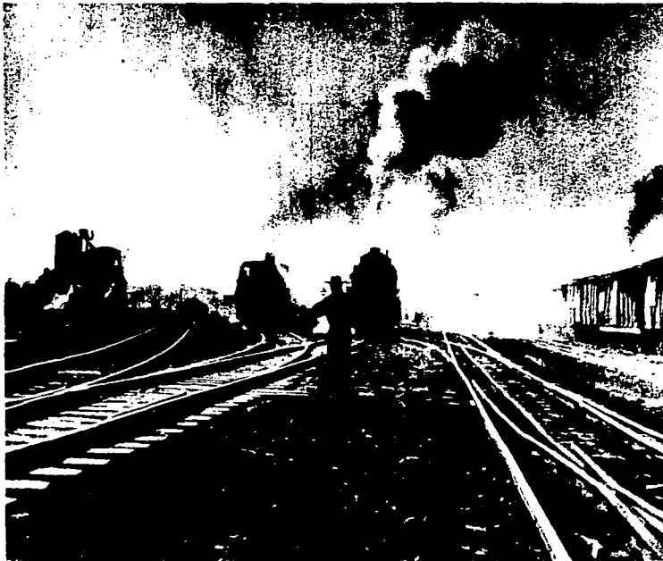
Patios de la estación de Buenavista
