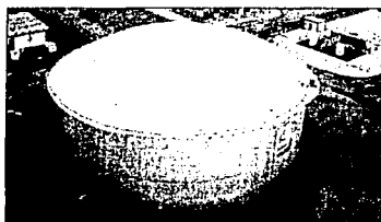
(f) Tanque de almacenamiento de agua, falla en conexiones, Santa Rosa, 1965
