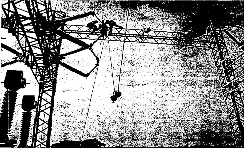
FOTO V.2. MONTAJE, TENDIDO Y CONECTADO DE BUSES
