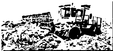
Foto.23 Compactación de residuos con un tractor de rodillos dentados
