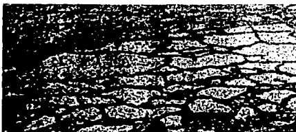
Figura 20 Agrietamiento de carpeta en forma de piel de cocodrilo.
