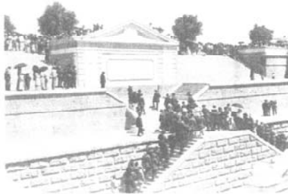
Inauguración de las obras del desagüe en 1900
