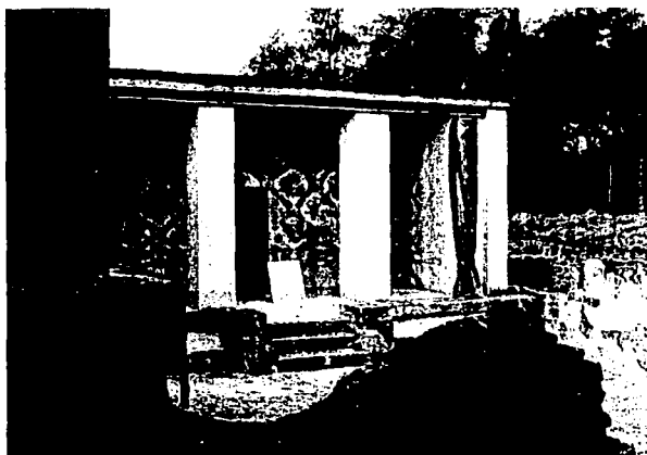
Foto 3 Vista del Patio Blanco. Templo Sur.
