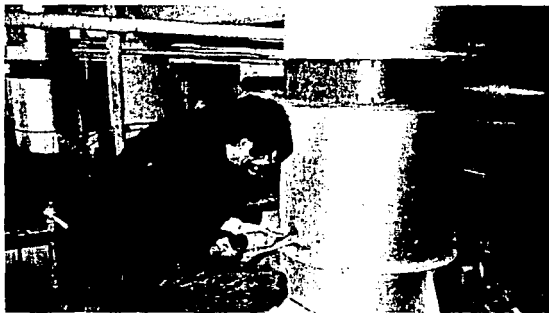
INSTALACIÓN DE SONDAS PARA EXTRACCIÓN DE GASES DE COMBUSTIÓN
