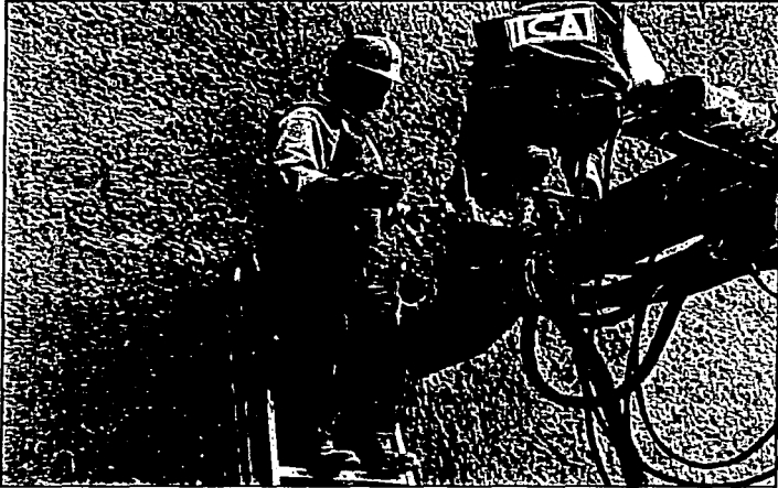
Figura 22 Perforación de Anclas
