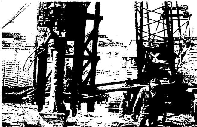
Este procedimiento se repitió hasta que se hincaron todos los pilotes. Se llevó un registro de la ubicación de cada pilote en la planta de cimentación, la fecha de hincado, el nivel de terreno antes del hincado y el nivel de la cabeza inmediatamente después del hincado.
