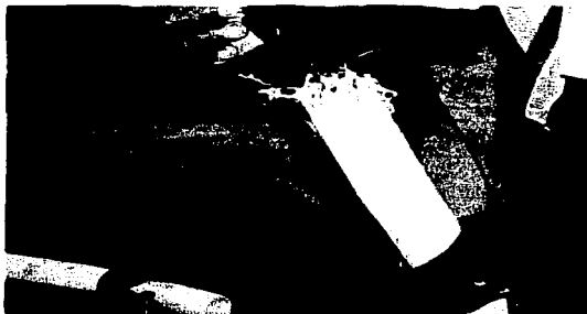
FOTO # 32 Personal raspando la superficie lisa del tubo por electrofusionar.
