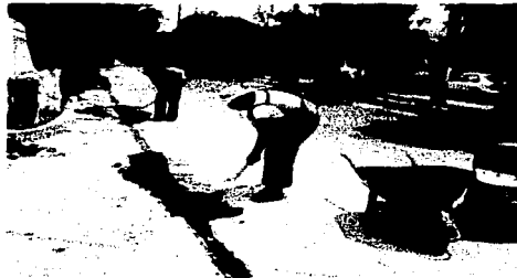
FOTO # 49 Rastrilleros extendiendo la mezcla asfáltica.
